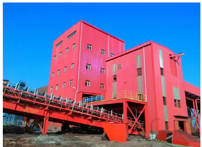
铁矿石商检采制样系统
